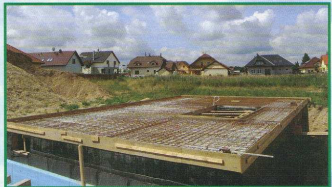
Hotový suterén, podlaha 1. NP připravena k betonování (Zdeněk Baxa)
