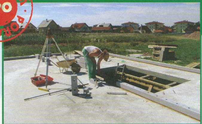
Provádění první řady zdiva ze speciálních bloků KS-ISO Kimmsteine omezující tepelný most mezi stěnami domu a zemí nebo suterémem (Zdeněk Baxa)
