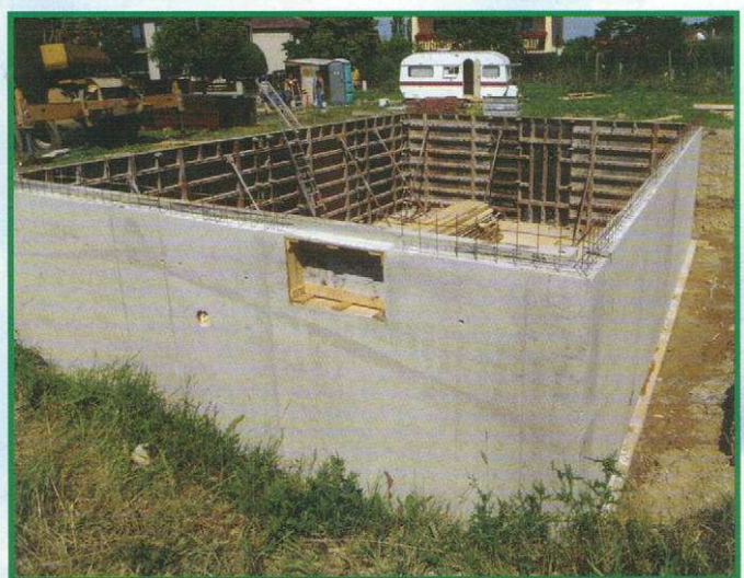
Betonování suterénních stěn (Zdeněk Baxa)
