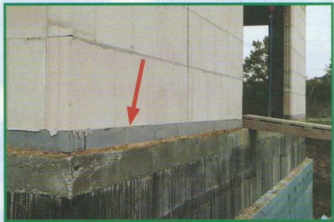
První řada zdiva ze speciálních bloků pro potlačení tepelného mostu KS-ISO Kimmsteine (označeno šipkou) u podsklepené varianty domu (ENVIC, o.s.)
